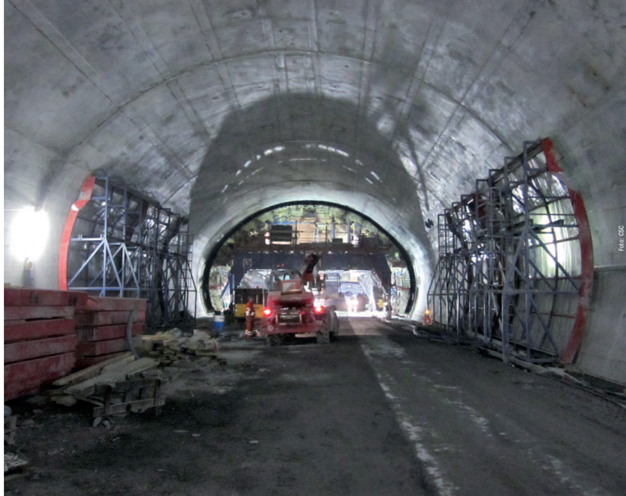
Bauarbeiten an der Tunnelumfahrung Eyholz bei Visp.
